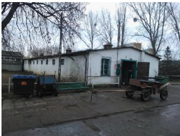
Fot. ogólna budynku
